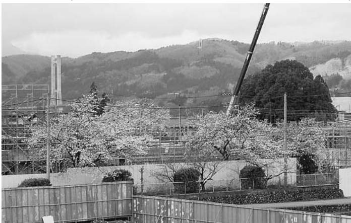
工事請負変更契約の締結議案(秩父第一中学校)
