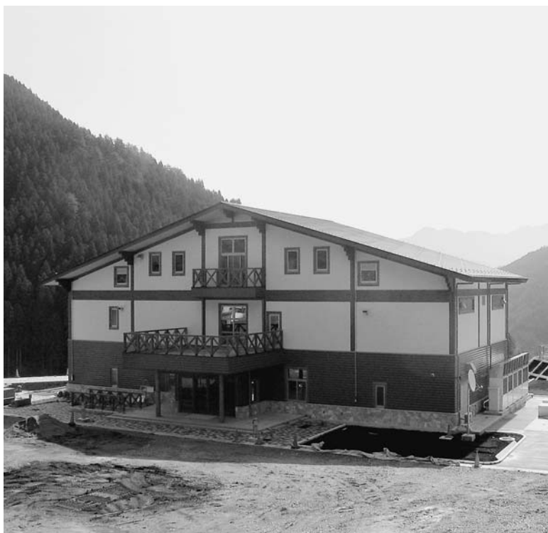
(仮称) 滝沢園地センター棟
