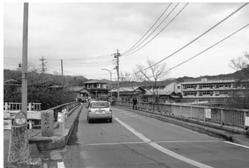
国道140号上田野地内安谷橋
